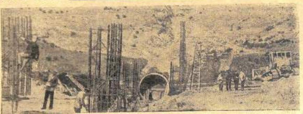
**СТАВРОПОЛЬСКАЙ НЫРАЙ.** Узәлинирга бәрт табығанда суюх сиргэ Улахан Ставропольсайдасы канал үңүс уечаратын тутуу ыбыллар. Изначалы аңоросчулар ус металлический дюкерлер монтистылхтара уонна 7 километр үүннанах тоннелер хәньяхтара.
